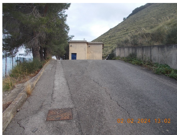
Foto del piazzale e della strada di accesso privato dove verrà posata la cabina elettrica prefabbricata con base in cemento armato e dove si effettuerà sottotraccia la posa del cavidotto elettrico con i collegamenti di servizio.
