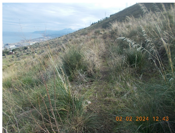
Foto scattata verso Est sulla traccia dell'interramento dell'acquedotto, dove la vegetazione erbacea ha colonizzato lo scavo
