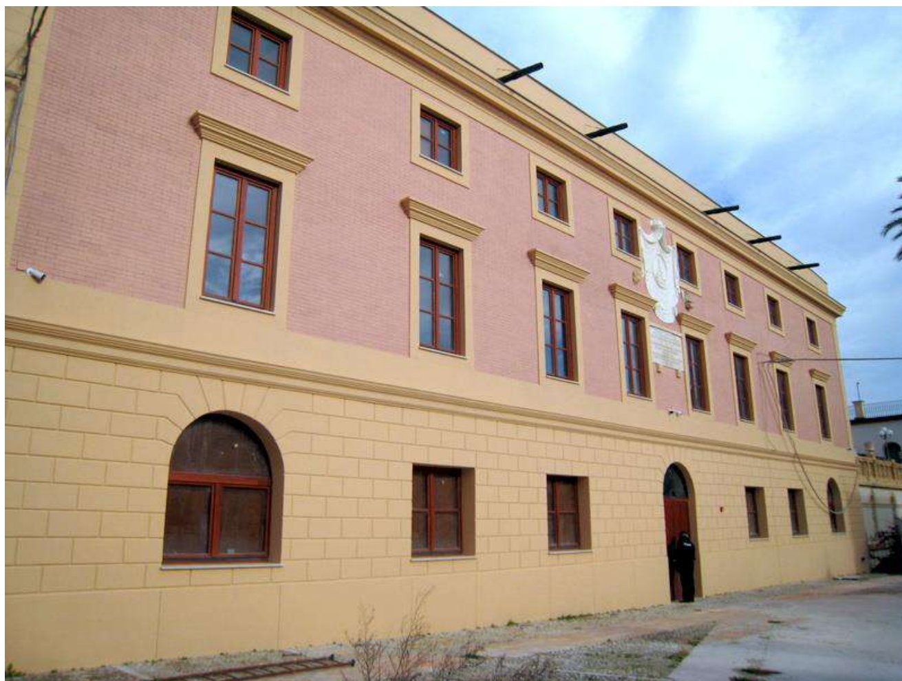
Foto n. 206. Il prospetto principale sulla Piazza come appare al termine dei lavori di restauro.
