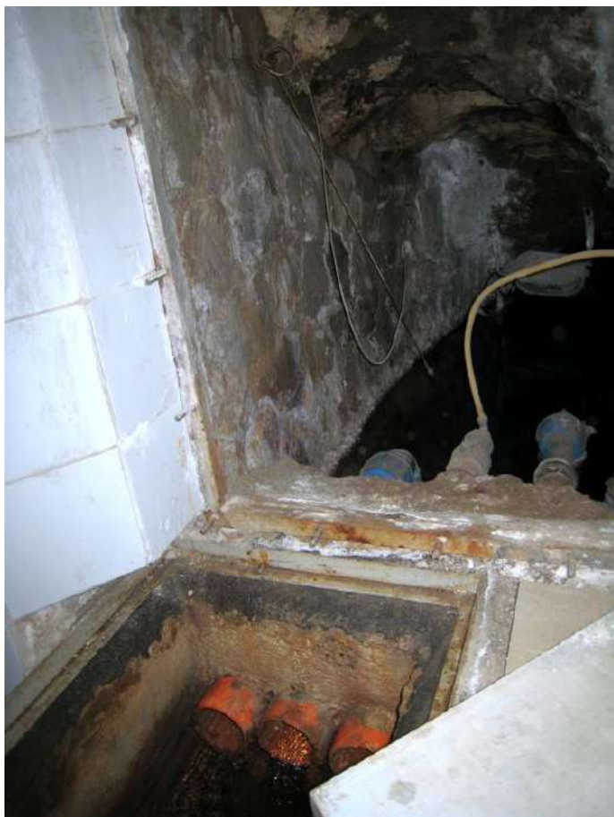
Foto n. 223-224. La nicchia con le pompe che portavano l'acqua al Grand Hotel ed il pozzetto del sopra livello. Da lì le acque vengono dirottate verso la fognatura.
