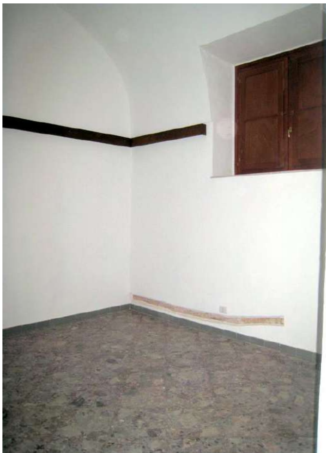
Foto n. 213. La sala di Dx dalla quale parte la scala che raggiunge il piano interrato.
