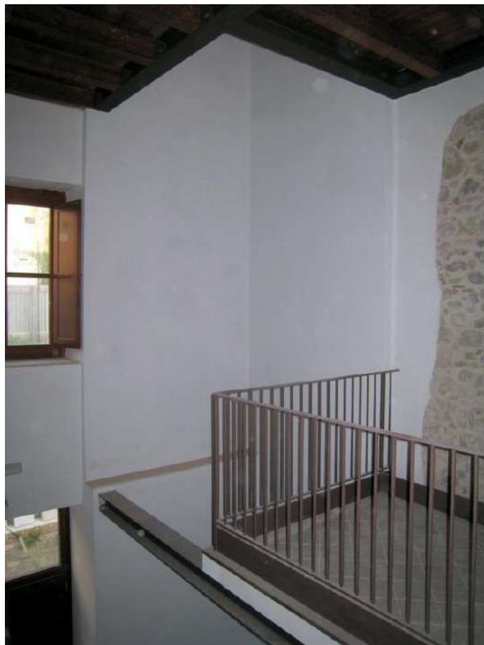
Foto n. 229. Vano ascensore al 1° piano e tavoliere di sbarco.
