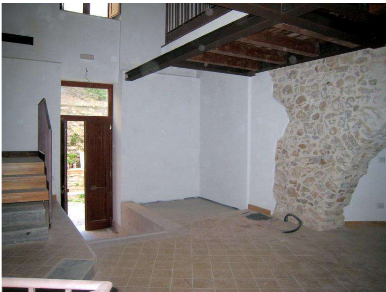
Foto n. 226. Accanto all'intesso, sulla Dx, il vano scensore già predisposto per la furura collocazione.
