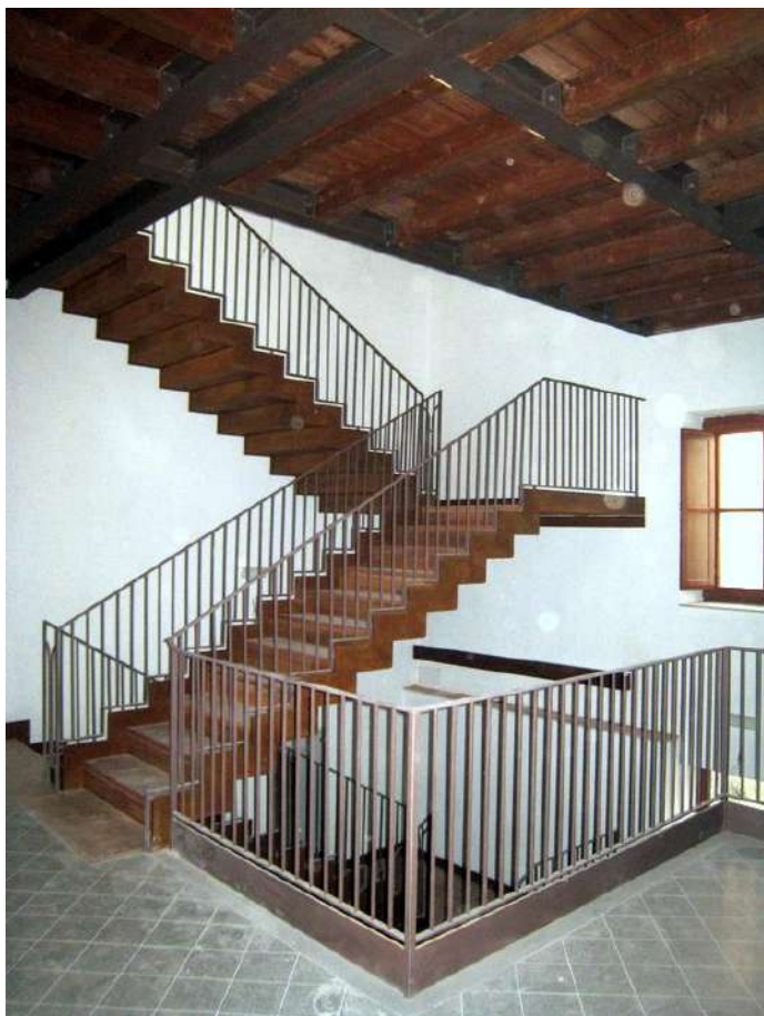
Foto n. 228. La scala che collega il 1° con il 2° piano.
