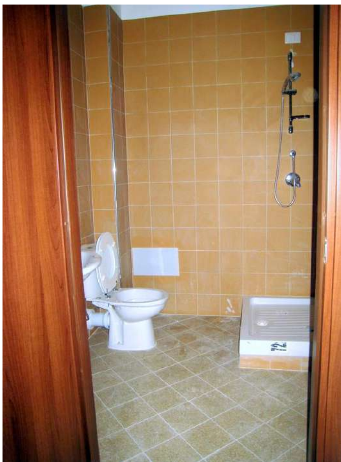
Foto n. 246. La tipologia dei bagni è uguale a quella del piano inferiore.
