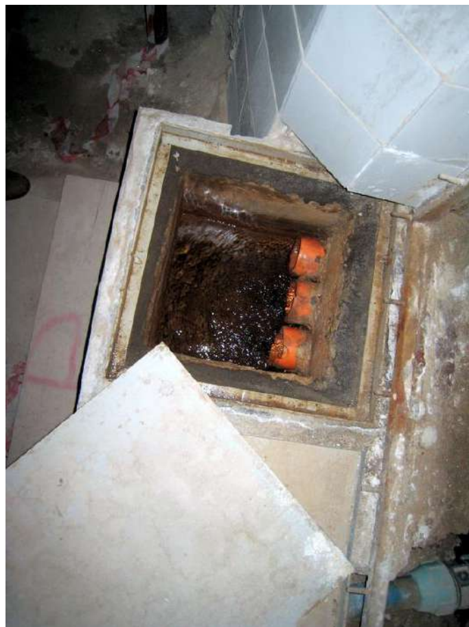
Foto n. 223-224. La nicchia con le pompe che portavano l'acqua al Grand Hotel ed il pozzetto del sopra livello. Da lì le acque vengono dirottate verso la fognatura.
