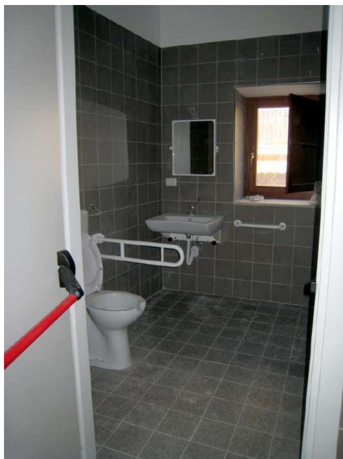
Foto n. 250. W.c. per i diversamente abili.
