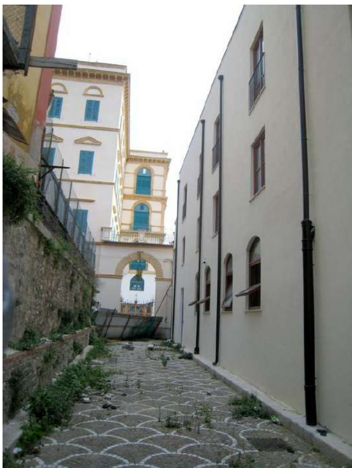
Foto n. 208. Il retro prospetto, Via piano delle Carrozze. dal retro prospetto.
