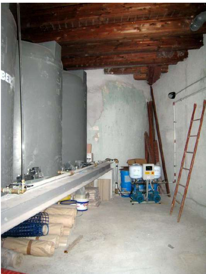
Foto n. 209. Locale di riserva idrica con accesso dal retro prospetto.
