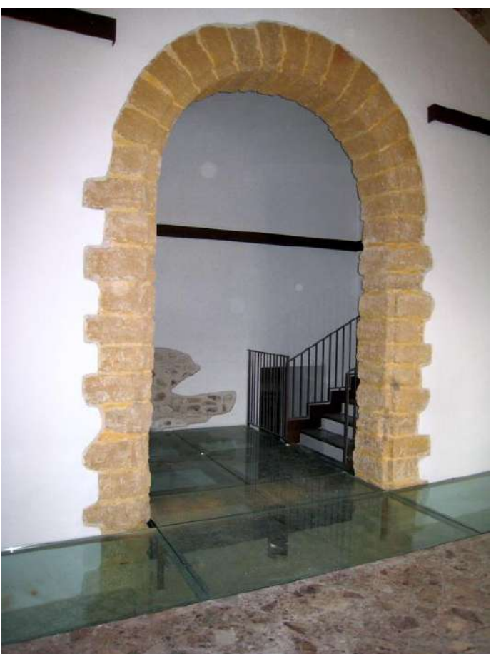
Foto n. 211. Dettaglio del pavimento in vetro per consentire la visione delle mura di epoca romana scoperte nel piano interrato.
