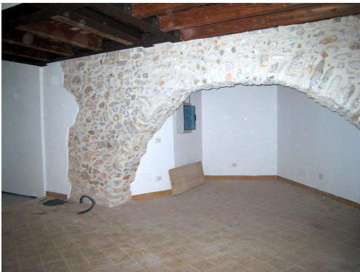
Foto n. 227. Vano adiacente all'ingresso da dove si sviluppa la scala e da dove si avvierà l'ascensore.
