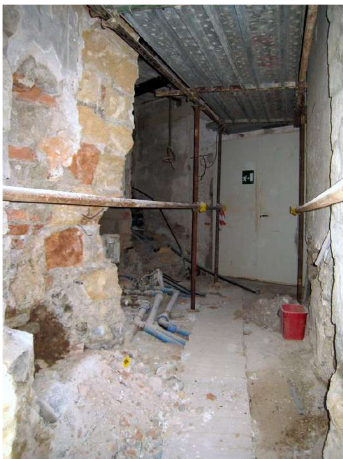
Foto n. 221. Il percorso continua fino a.....
