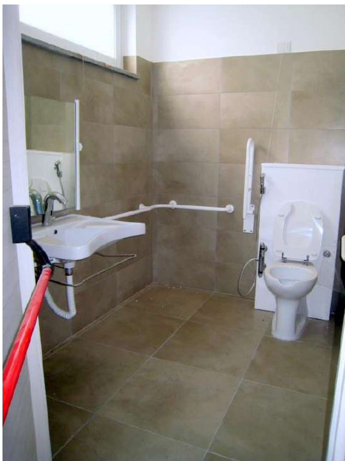
Foto n. 124. W.c. per i diversamente abili.
