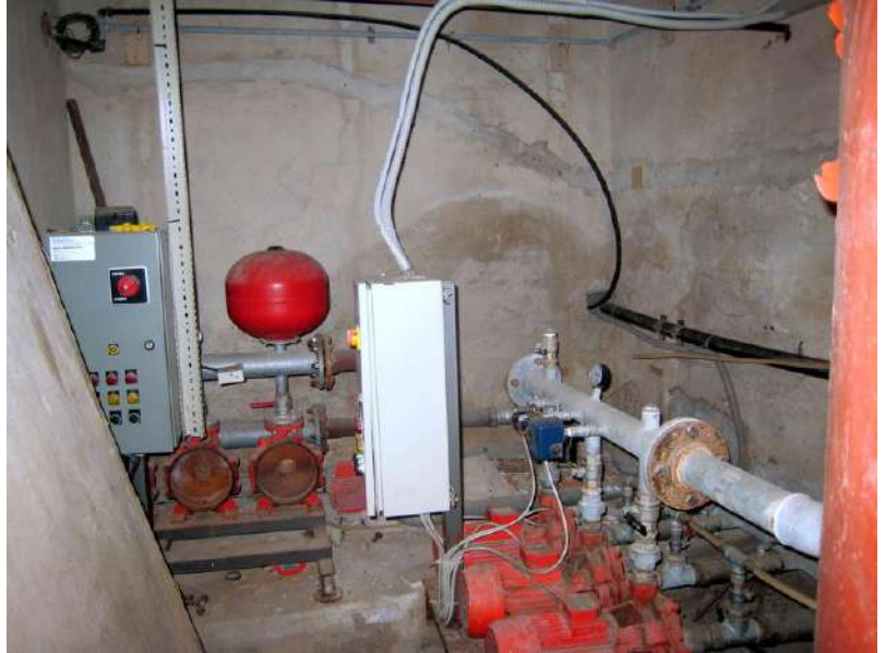
Foto n. 191-193. Il locale autoclave con gli impianti idrici ed elettrici. Le condizioni dello stesso sono cattive a motivo delle infiltrazioni d'acqua piovana.
