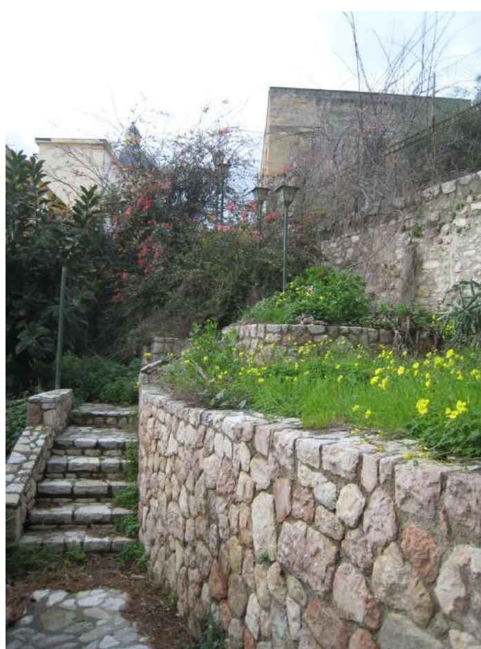
Foto n. 161. La scaletta che conduce fino all’ingresso pedonale
