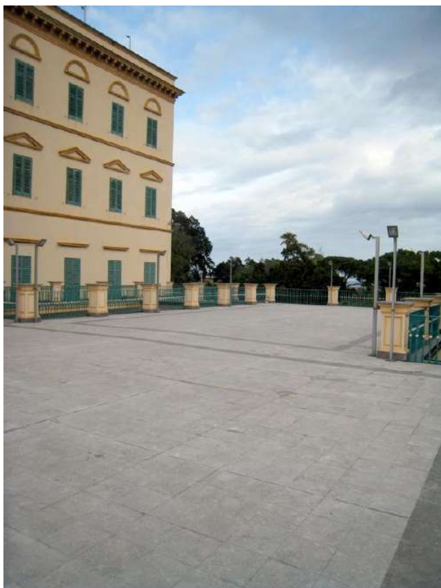
Foto n. 12. Altra porzione di terrazzo al 2° piano.
