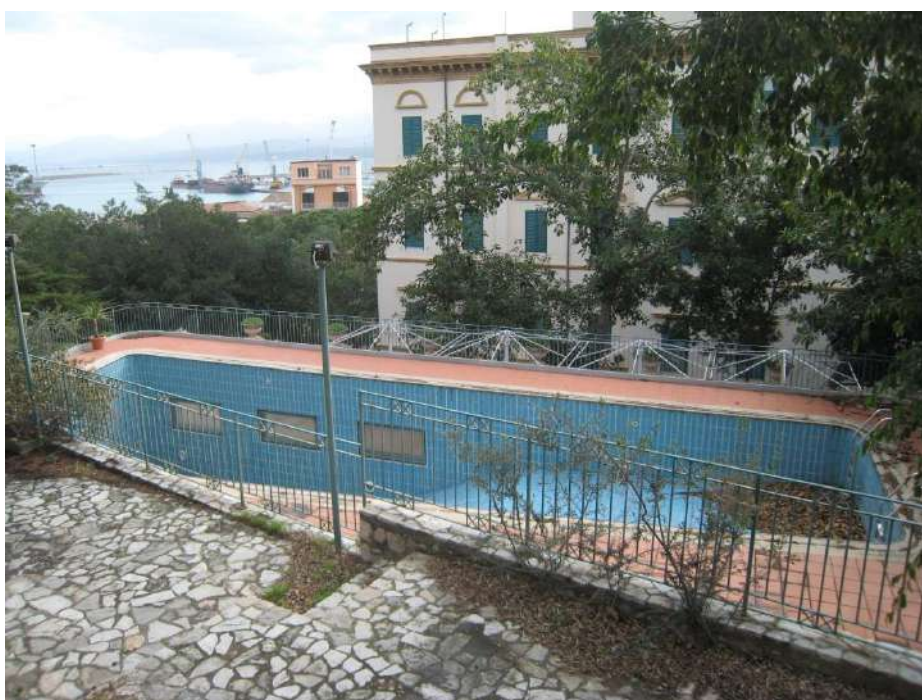
Foto n. 150. La piscina vista da uno dei terrazzamenti pavimentati posti a monte. L'impianto di illuminazione su pali è vandalizzato ed i cavi sono stati rimossi. L'impianto di depurazione dell'acqua della piscina è ormai inservibile.
