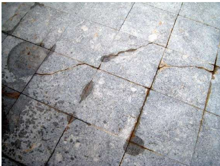
Foto n. 128-131. La pavimentazione con marmette in Billiemi del terrazzo presenta diverse mattonelle lesionate.
