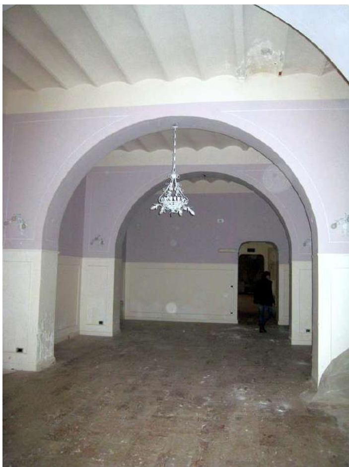
Foto n. 48. La sala colazione adiacente a quella da pranzo.
