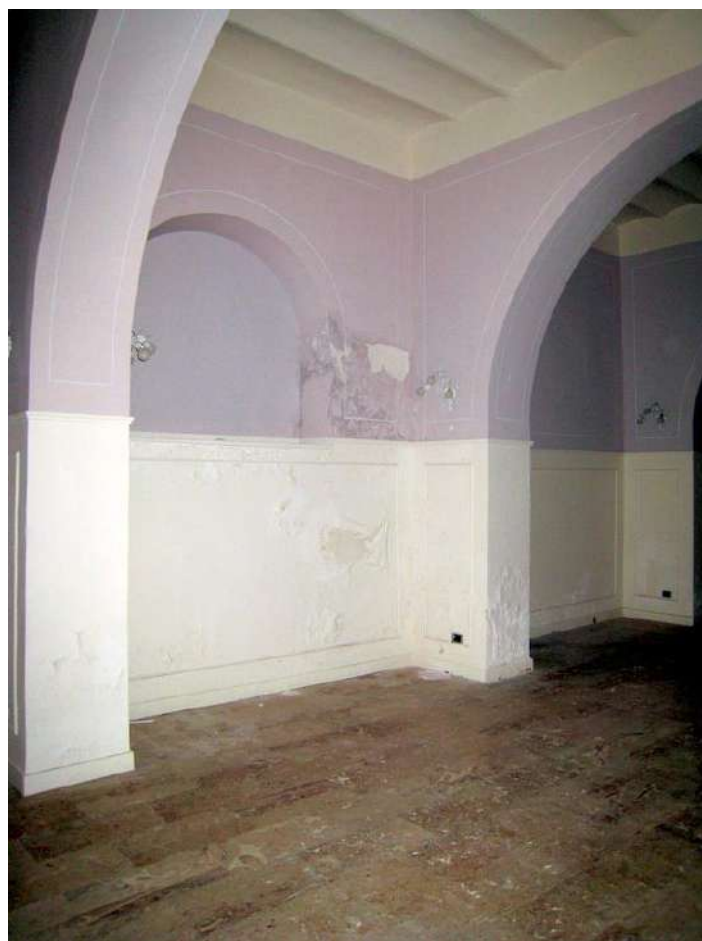
Foto n. 49. L'umidità ha consunto pitture ed intonaci.
