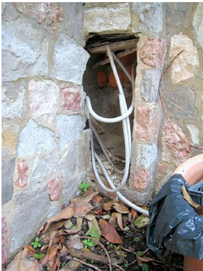
Foto n. 177-177. Cavidotti aperti e cavi sfilati, quelli ancora in sede sono gli ultimi rimasti.
