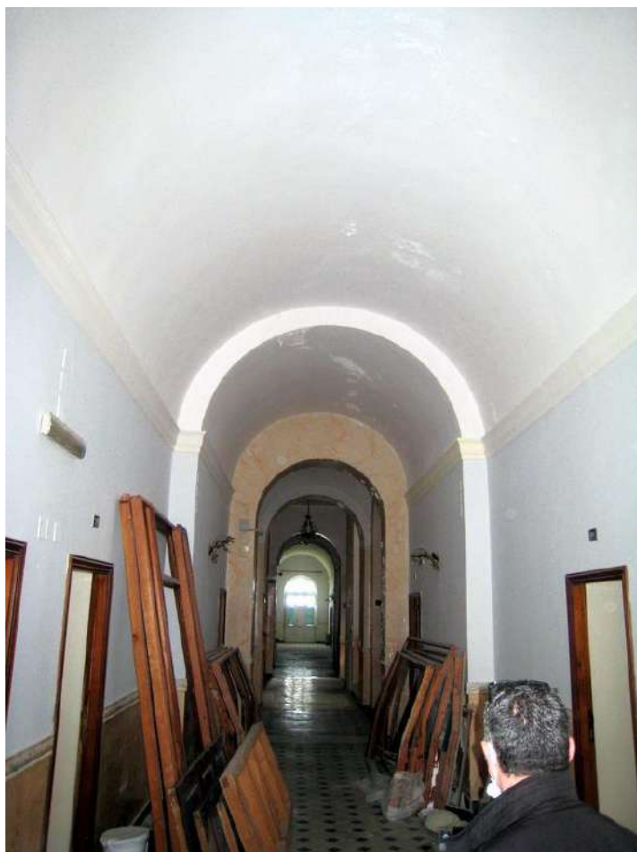
Foto n. 107. Corridoio lato Sud.
