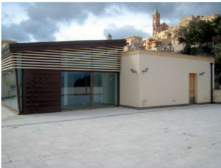
Foto n. 14. Il Roof Garden visto da Nord verso Sud.
