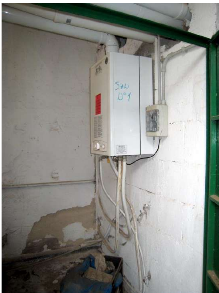
Foto n. 188-189. Le nuove caldaie installate in occasione dei lavori nel Roof Garden.
