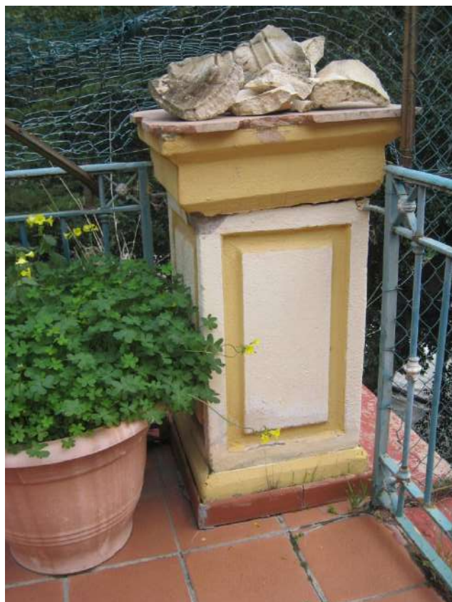
Foto n. 154-155. Buona parte dei basamenti delle fioriere sono spaccati e/o lesionati, qualche fioriera è rotta.
