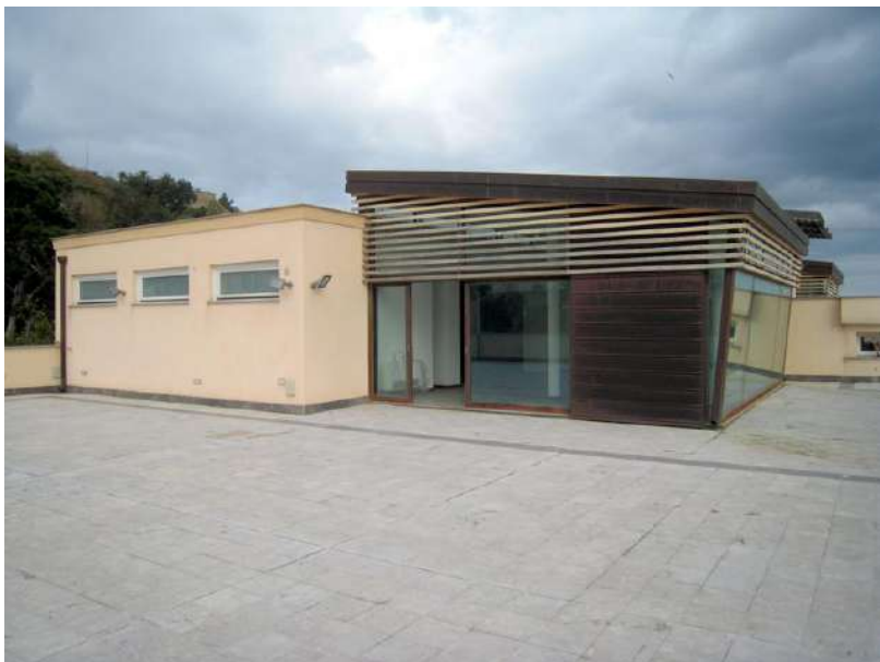
Foto n. 13. Il Roof Garden, ultimo piano, visto da Sud verso Nord sul lato Nord.
