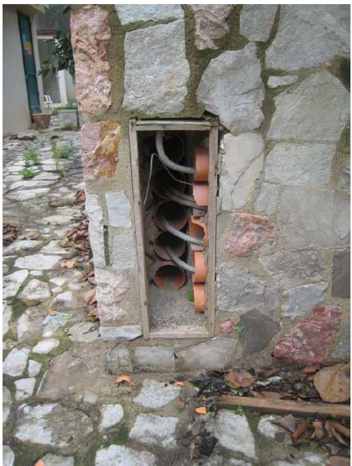
Foto n. 177-177. Cavidotti aperti e cavi sfilati, quelli ancora in sede sono gli ultimi rimasti.
