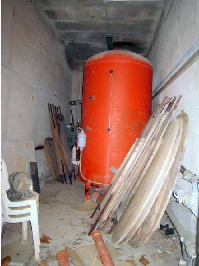
Foto n. 191-193. Il locale autoclave con gli impianti idrici ed elettrici. Le condizioni dello stesso sono cattive a motivo delle infiltrazioni d'acqua piovana.
