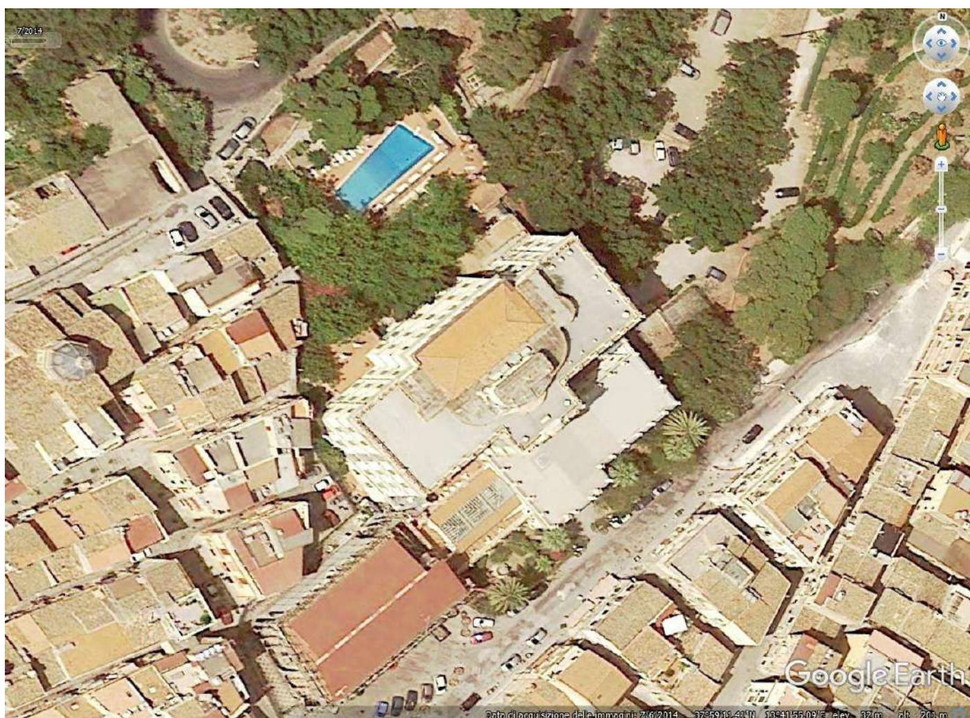
Foto n. 6. Dettaglio dell'albergo con le aree esterne e pertinenziali anteriore e posteriore.
