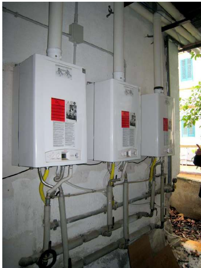
Foto n. 188-189. Le nuove caldaie installate in occasione dei lavori nel Roof Garden.
