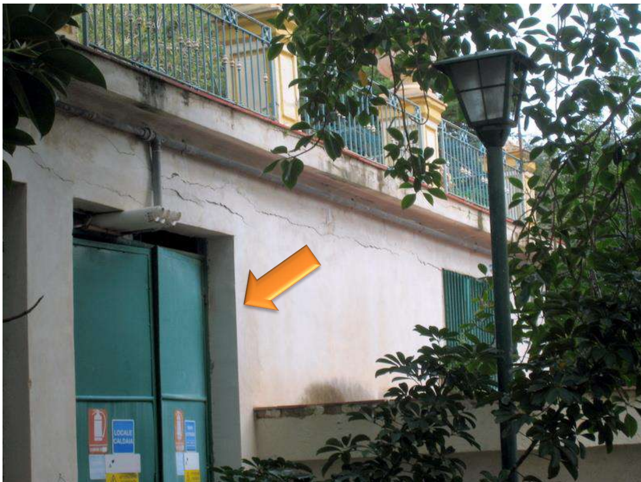
Foto n. 181. Il gruppo dei locali tecnici si sviluppano sotto il terrazzo a livello della piscina. Gli intonaci sono lesionati a causa dell'ossidazione delle barre di armatura che gonfiandosi hanno lacerato il rivestimento. La freccia indica l'ingresso al locale caldaie.
