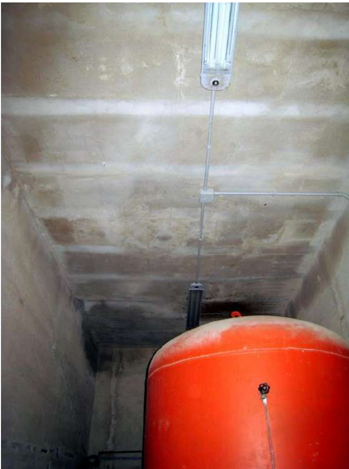
Foto n. 191-193. Il locale autoclave con gli impianti idrici ed elettrici. Le condizioni dello stesso sono cattive a motivo delle infiltrazioni d'acqua piovana.
