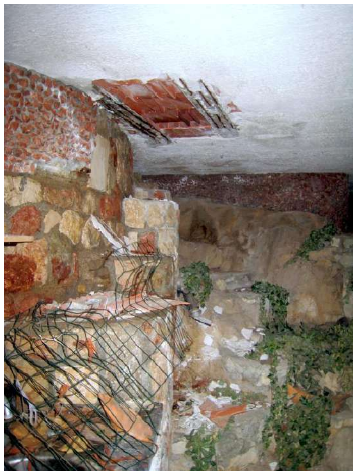
Foto n. 169-170. Il "Bar" è insinuato nella roccia ed ha il solaio di copertura in pessime condizioni.
