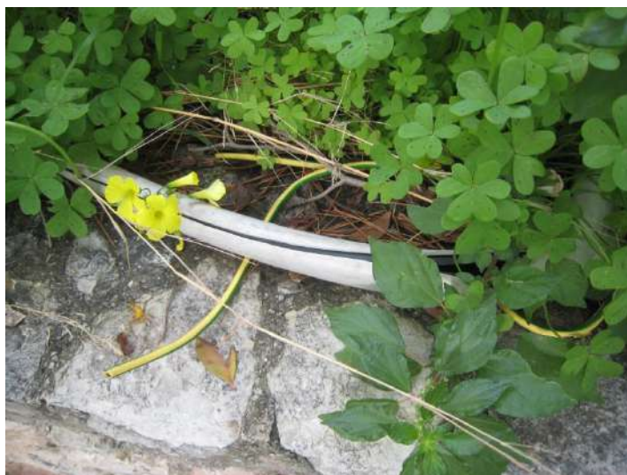
Foto n. 157-158. Cavi dell'impianto di illuminazione esterna tranciati con il rame che è stato prelevato dai ladri.
