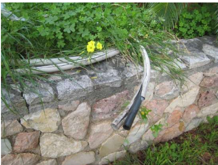
Foto n. 157-158. Cavi dell'impianto di illuminazione esterna tranciati con il rame che è stato prelevato dai ladri.
