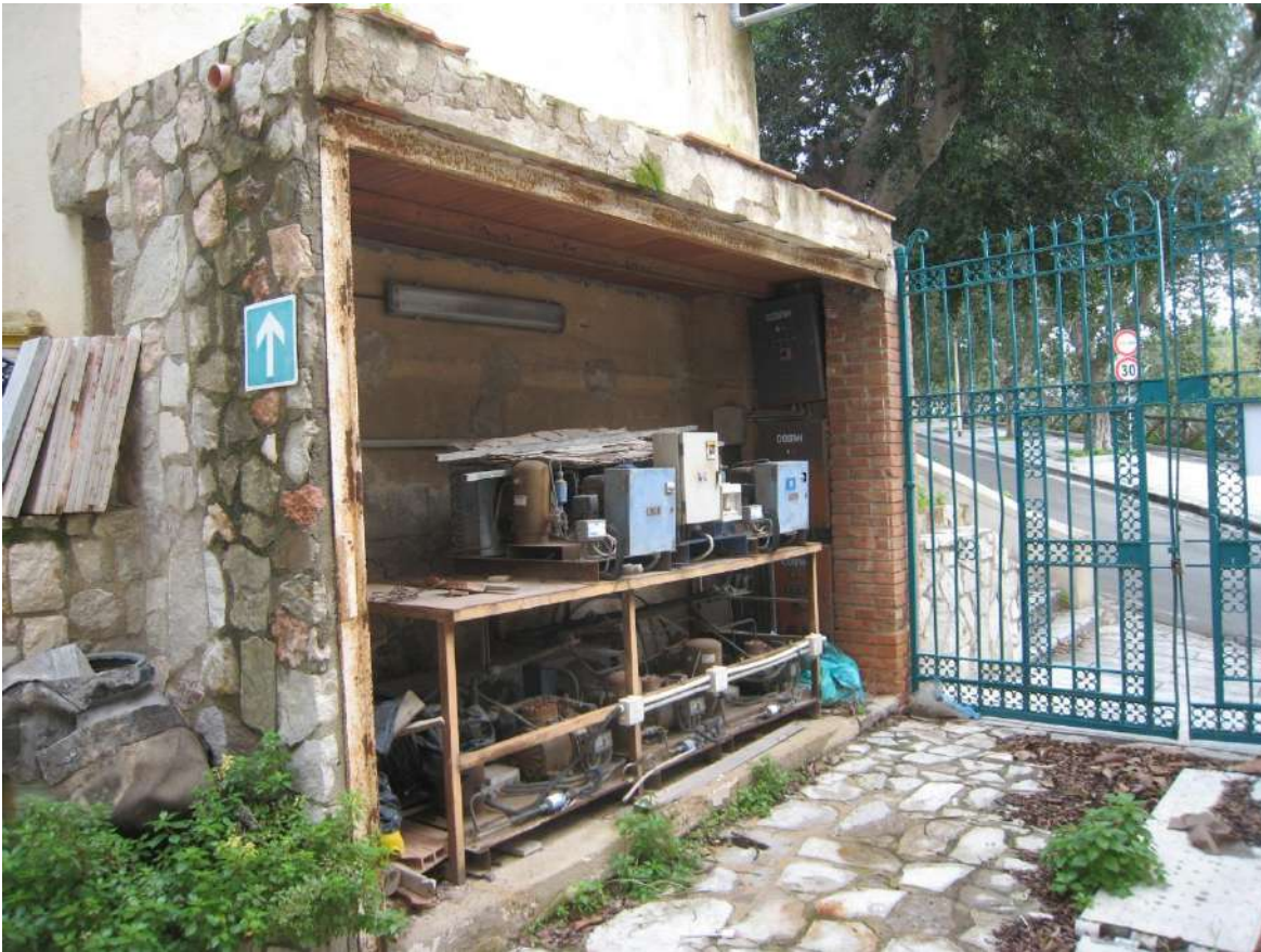
Foto n. 194. Trattasi di un locale posto a ridosso del cancello di ingresso dalla “Serpentina” che ospita compressori ormai in disuso.
