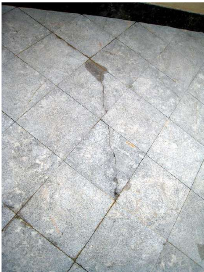
Foto n. 128-131. La pavimentazione con marmette in Billiemi del terrazzo presenta diverse mattonelle lesionate.
