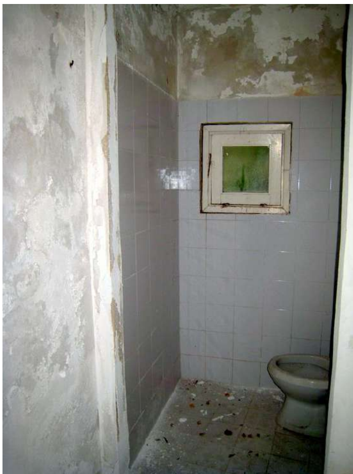
Foto n. 166. Uno dei due w.c.
