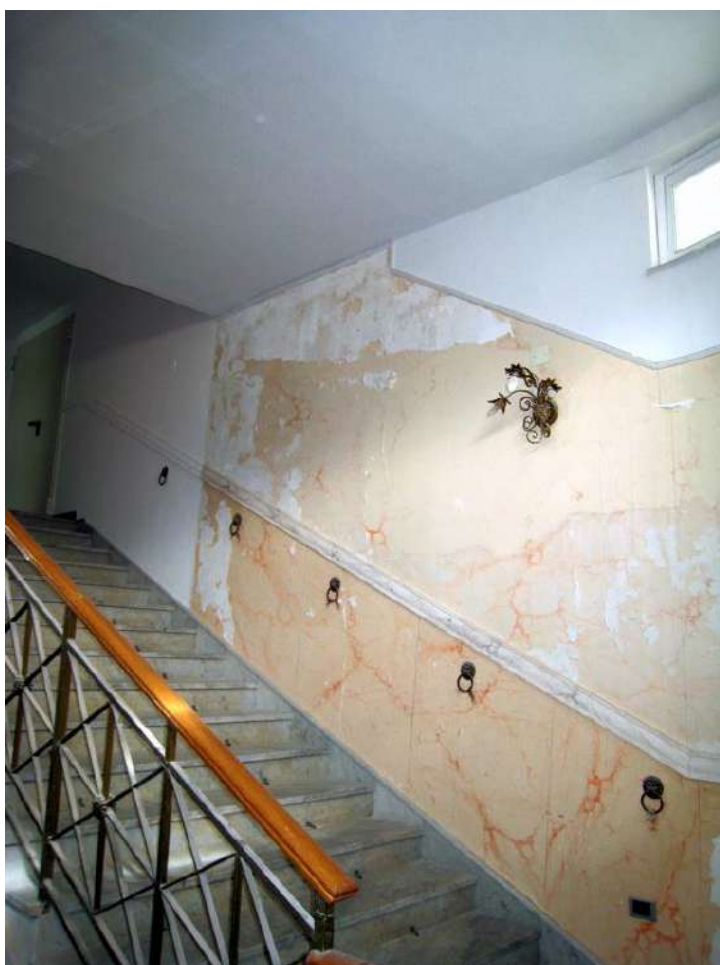
Foto n. 104. Ancora le pareti della scala.
