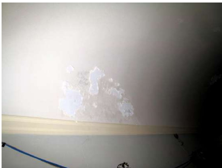
Foto n. 75-76. Umidità ed esfoliazione della pittura.
