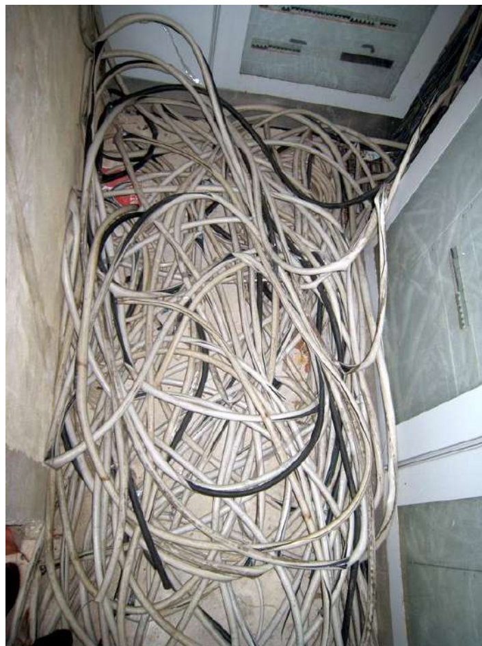
Foto n. 139-141. Lo scempio compiuto dai ladri di rame. Hanno sfilato i cavi e danneggiato gli armadi.
