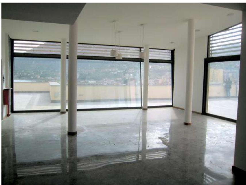
Foto n. 120. L'ampliamento Sud oggetto di recente ristrutturazione secondo i dettami della Soprintendenza.
