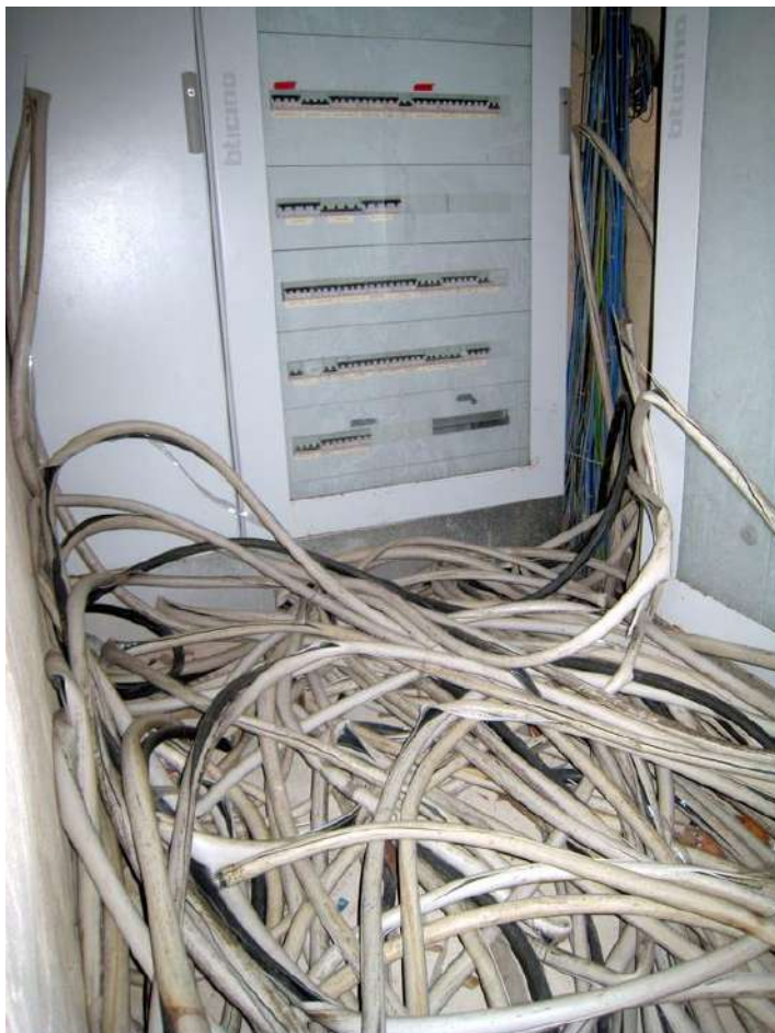
Foto n. 139-141. Lo scempio compiuto dai ladri di rame. Hanno sfilato i cavi e danneggiato gli armadi.
