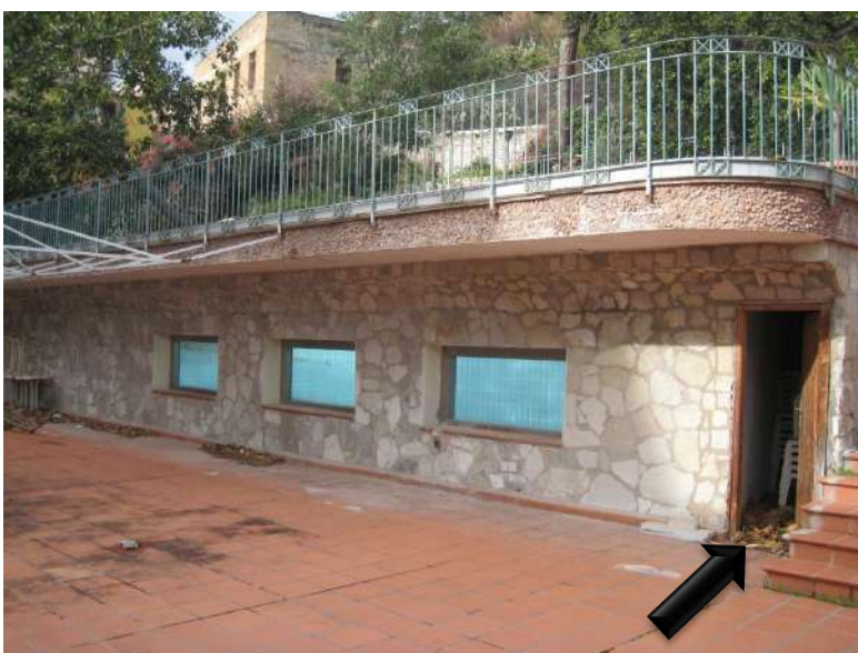
Foto n. 156. Gli oblò rettangolari della piscina. La freccia nera indica l'ingresso al magazzino che si sviluppa a fianco della vasca e sotto la scalinata.
