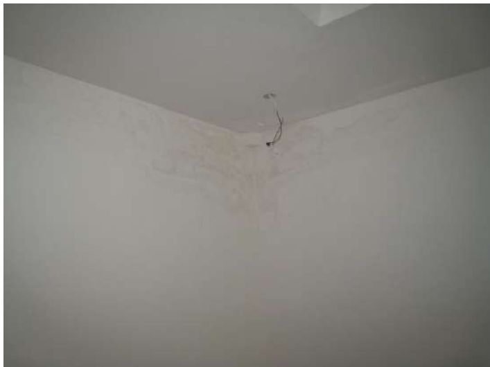
Foto n. 132. Tracce di umidità nell'angolo Nord-Ovest del salone. Foto n. 133. I nuovi quadri elettrici.
