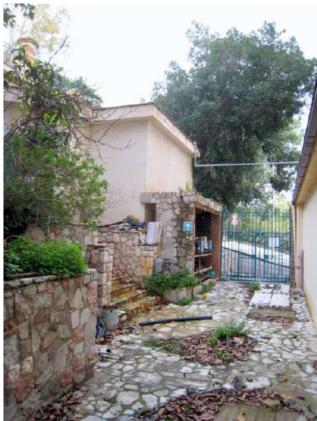
Foto n. 136. La cabina Enel ed il locale aperto che ospita i vecchi compressori delle celle frigorifere.
